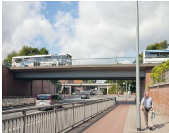
Kommt neu: Die Brücke über die Dahlenburger Landstraße wird ersetzt. Die neue ist auch für Gelenkbusse geeignet.
