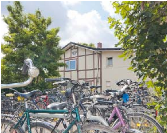
Kommt weg: Die alte ESV-Turnhalle am Westbahnhof weicht einem neuen Fahrrad-Parkhaus.
