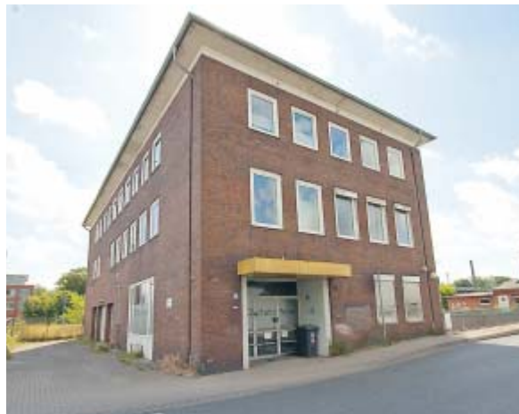
Kommt weg: Die ehemalige Bahnpost wird abgerissen. Sie schafft Platz für die ZOB-Erweiterung.
